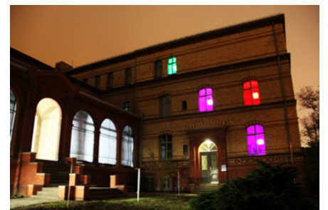
Sanierter Westflügel (Fotos: Nerlich) und Beleuchtung des Topoi-Hauses zur Einweihungsfeier (Foto: Nennstiel)
